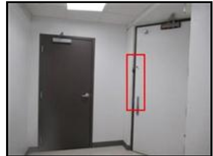
D. Picture 3 Padlocked Door
